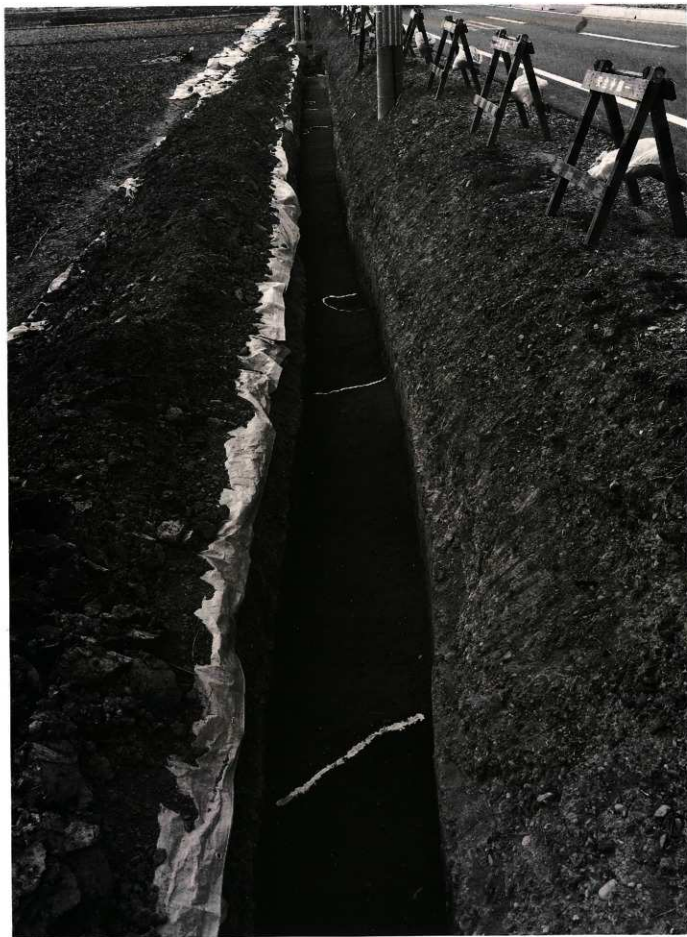
(1) 調査完了写真 (東より)
