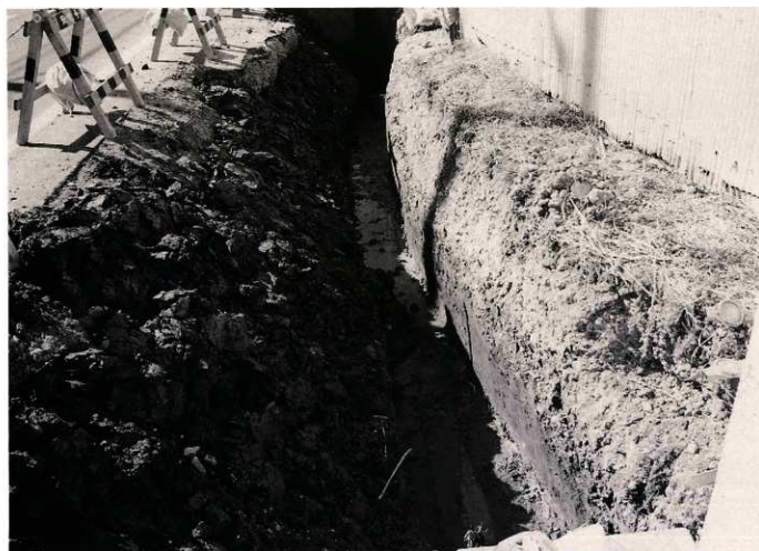
(2) 北地区完掘写真 (東より)
