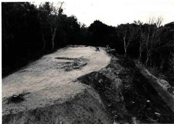
(1)G地区完了写真(南より写す)
