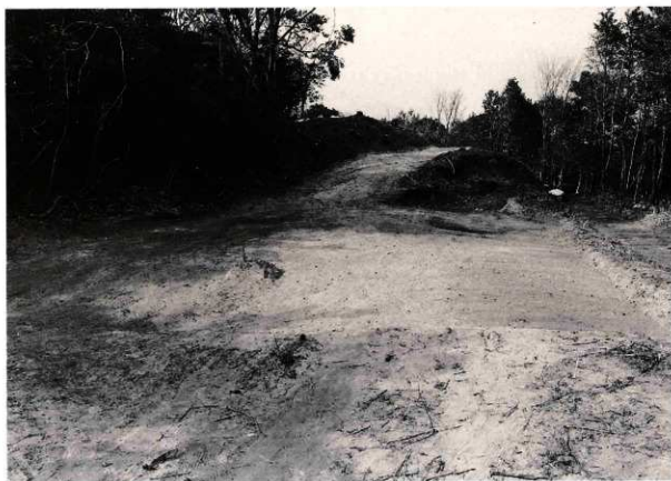
(2)G地区完了写真(南より写す)
