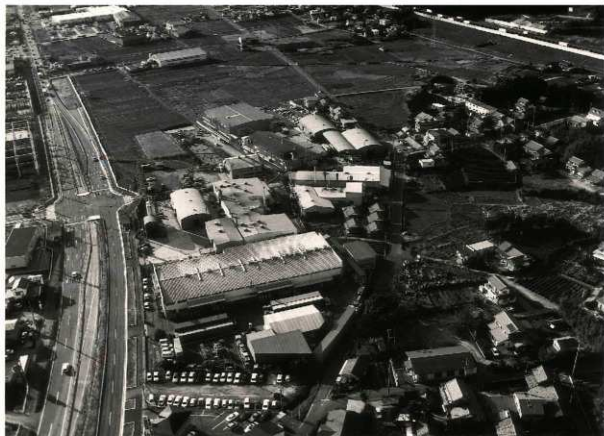
(1) 調査地全景（東より）
