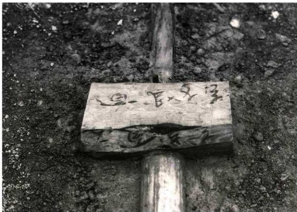
流路内竹樋管ジョイント部
