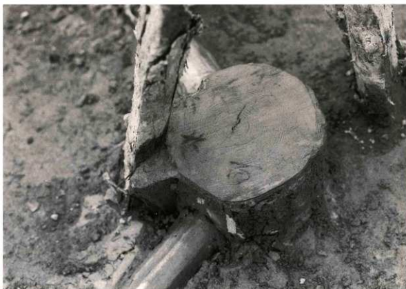
流路内竹樋管ジョイント部
