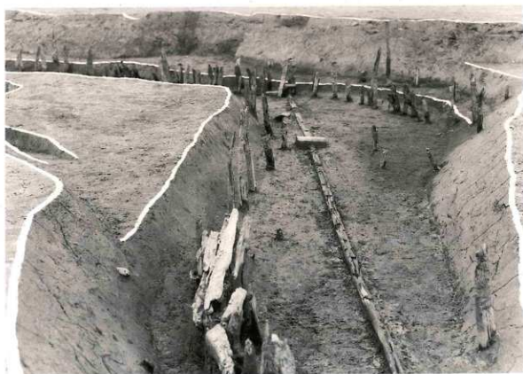
流路内護岸施設及び竹樋管
