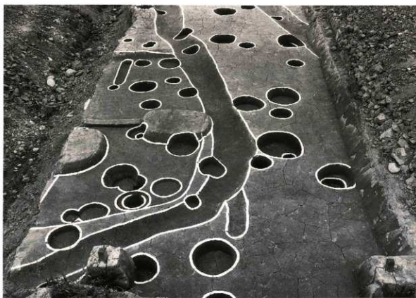
7・14号掘立柱建物 (東より)
