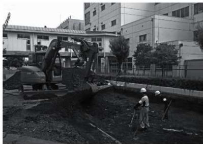
第1図 1802次 表土掘削風景
