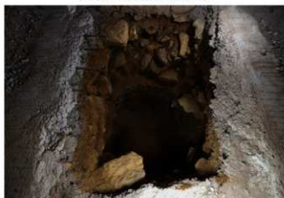
3 G 完掘状況（北から）
