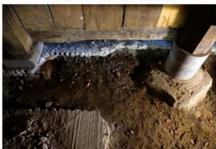
5 G 調査前状況 (東から)
