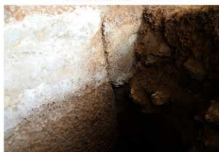
2 G 石積みとの境界状況 (北東から)
