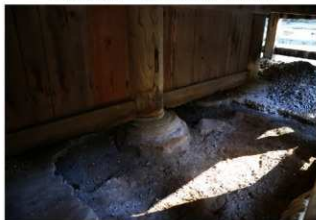
4 G 礎石周囲コンクリート掘削状況 (南西から)
