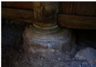
4 G 礎石上部検出状況 (南から)
