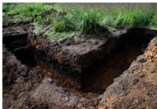
完掘状況 (南東から)
