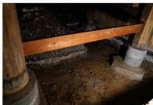
5 G 付近コンクリート撤去後状況 (北東から)
