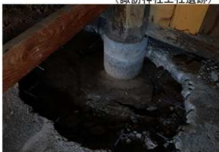
5 G 礎石上部検出状況 (東から)
