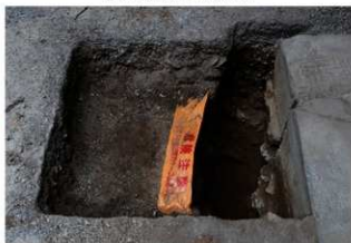
1 G 完掘状況（北から）
