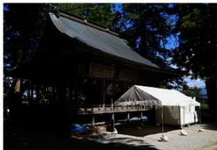
調査地全景（南から）
