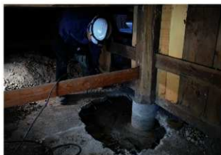
5 G 礎石周囲コンクリート掘削状況 (北東から)
