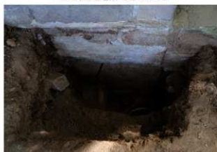
2 G 完掘状況 (北から)
