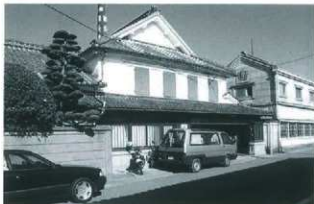
↓ 西矢原町の妻入町家と洋風建築
