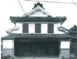
↓東唐人町北側の土蔵造町家 諸富弘家
