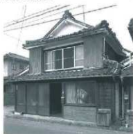
↑ 平入真壁造開放型 ↓ 小梁間下下屋開放型
