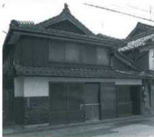
↑ 多様な立面形式 開放型と閉鎖型 妻入と平入 下屋無と下下屋 ↓ 片下屋開放型
