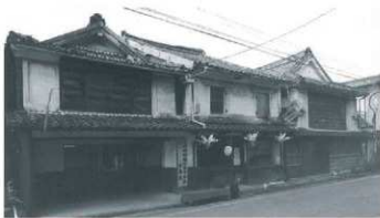
↑ 多様な立面形式 開放型と閉鎖型 妻入と平入 下屋無と下下屋 ↓ 片下屋開放型
