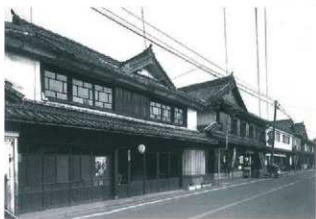
↑東宮野町東側の町家群 北方より
