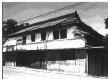
↑ 空き家になり老朽化が進む伝統家屋
