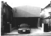
↑セットバックして建てられた新築家屋
