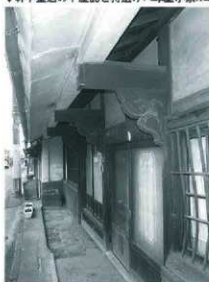
↑ 壁の石張壁と海鼠壁 諸富弘家 ↑ 軒下塗込の下屋庇と持送り下屋壁等 平井南吉家
