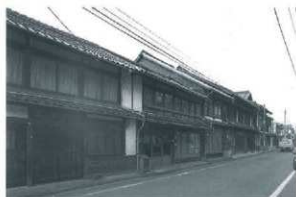
↑ 平入真壁造開放型 ↓ 小梁間下下屋開放型
