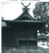
↓土橋八幡社神殿側面
