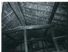
↑井上長蔵家倉庫小屋組
