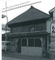
↑ 多様な立面形式 開放型と閉鎖型 妻入と平入 下屋無と下下屋 ↓ 片下屋開放型
