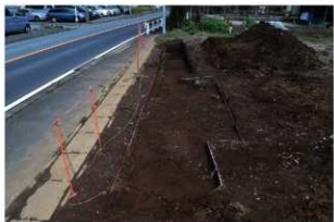
遺構確認状況（南から）
