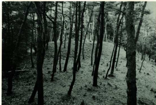
改修工事終了後の前方部（南から）
