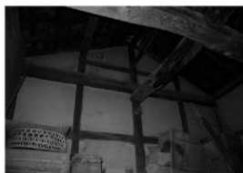
図 3-30 納屋南側室内小屋組み（南より）
