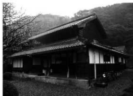
図 4-8 大鐘家住宅主屋 (南より)
