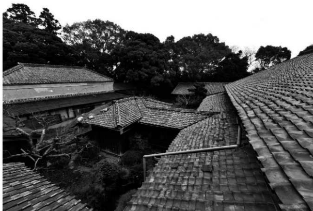
2. 屋敷地背面側（二階屋より望む）
