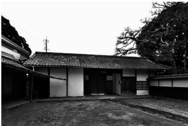
17. 長屋門背面全景（北より）
