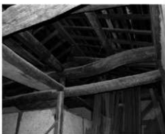
図 3-25 長屋門小屋組み (東より)
