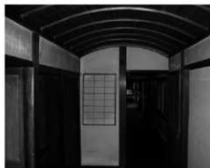
図 3-19 渡り廊下の蒲鉾天井 (北より)
