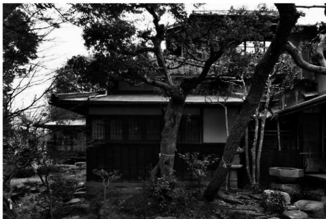
12. 風呂・便所棟側面（南面）
