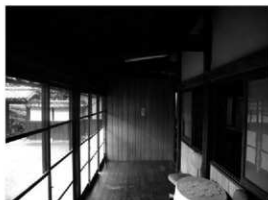
図 3-10 正面土間側の縁（東より）
