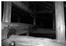
図 3-17 小屋組み（八畳間より奥座敷側をみる）
