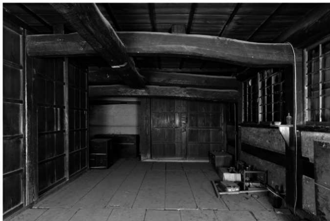
10. 主屋二階（西より）
