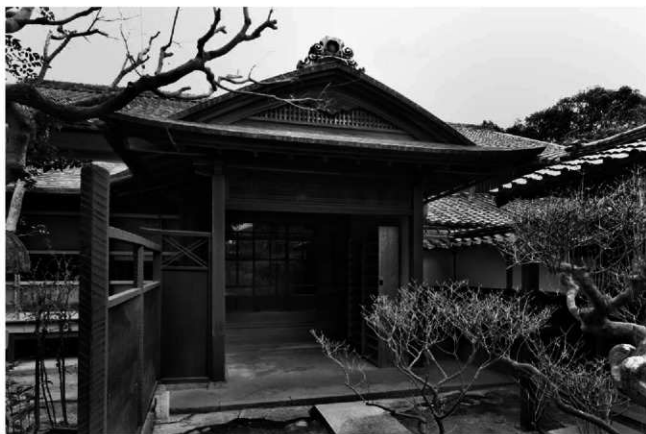
7. 主屋式台玄関（南より）
