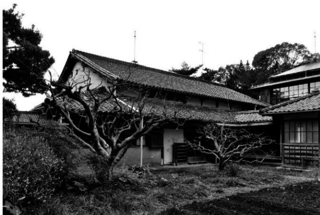
5. 主屋背面全景（北東より）
