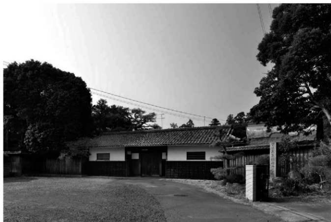
34. 沿道から見る長屋門（現況）
