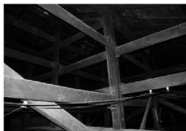
図 4-9 旧山崎家住宅西側小屋組み (床上部)
