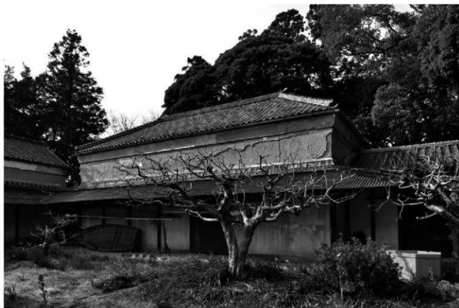
23. 北蔵全景（南東より）
