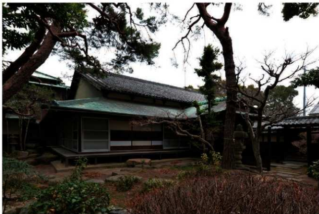
2. 主屋 正面全景（南西より）
