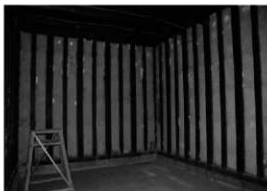
図 3-29 米蔵南側室内（北より）
