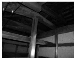
図 3-23 風呂・便所棟の小屋根組み
