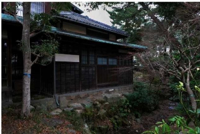
8. 風呂・便所棟 全景（北西より）
