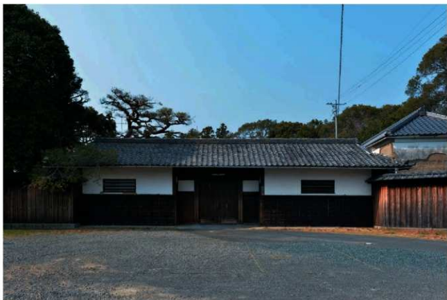
10. 長屋門 全景（南より）
