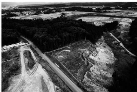
道跡遠景 (南西から)
