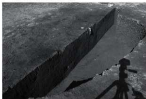
P-85 土層断面 (南西から)
