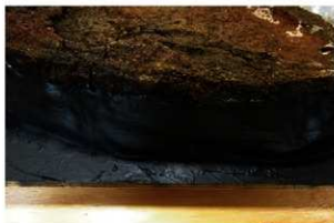
側面補強 使用薬剤：不飽和ポリエステル ガラスクロス
