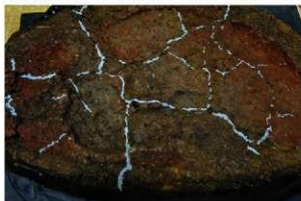
樹脂充填 使用薬剤：エポキシ樹脂
