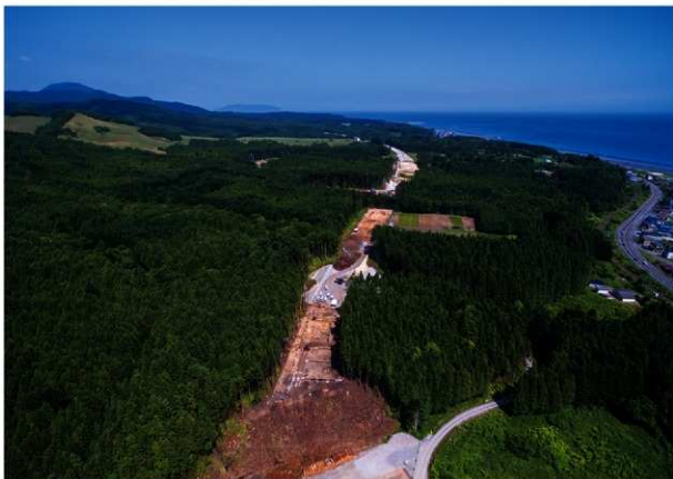
空撮 手前：幸連5遺跡 中央：幸連遺跡（西から）
