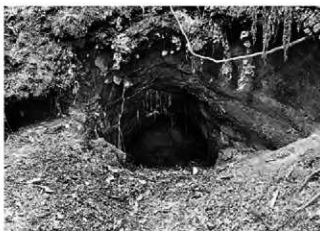
④ 3区隧道水路 流出口 開口部 (東から)
