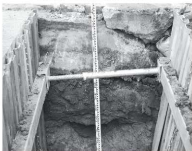
①地点土坑断面 (西から)
