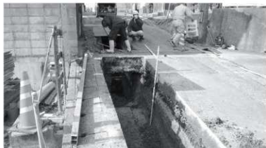
調査状況 (⑥地点から西方丘陵頂部を望む)
