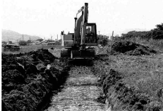
1. トレンチ掘削
