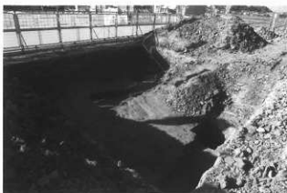
(6) 4区全景 (南東より)
