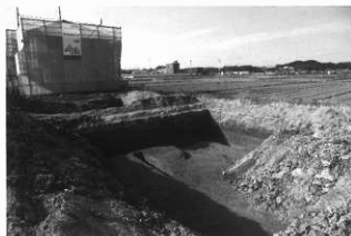
(1) 6区全景 (南東より)
