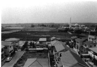
A. C区全景 (東から)
