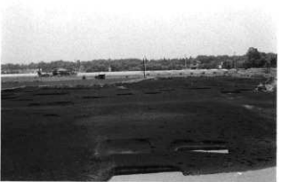
G. A・B区全景 (東から)
