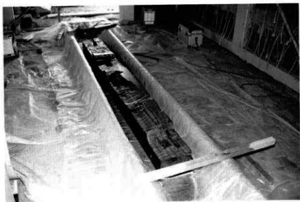
57 袖塙土台 防腐剤含浸
