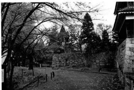
79 本丸西虎口整備 工事（施工前）
