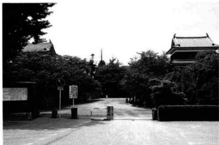
2 施工前 全景（夏期）
