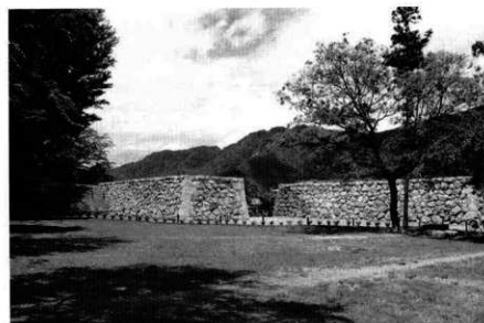
87 二の丸北虎口 整備工事
