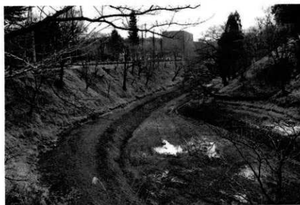
78 本丸掘浅せつ工事
