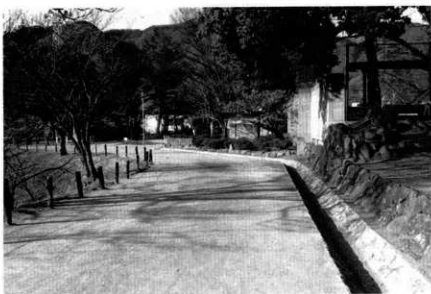
76 二の丸排水路 敷設工事
