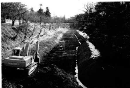
77 本丸掘浅せつ工事
