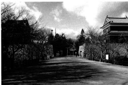
1 施工前 全景（冬期）
