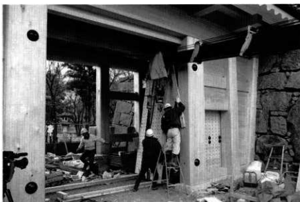
56 大扉 組み込み
