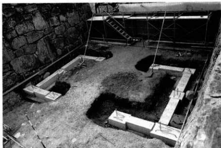
13 基礎コンクリート 打設
