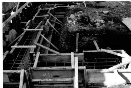
12 基礎工事 配筋
