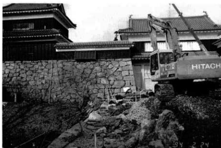
88 本丸東虎口 整備工事
