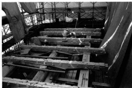
22 下層梁建込み加工
