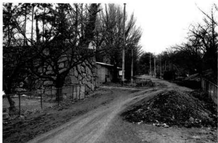
82 二の丸北虎口整備 工事（施工前）
