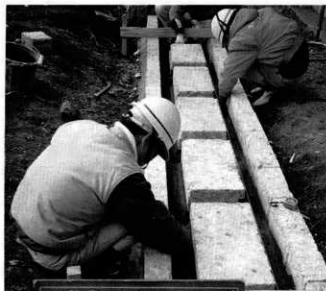
64 外構工事 雨落
