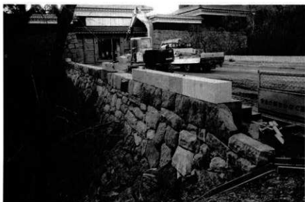
89 本丸東虎口 整備工事
