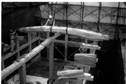
24 小屋梁建込み
