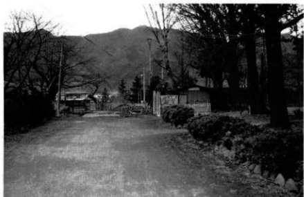
83 二の丸北虎口整備 工事（施工前）
