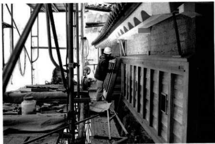
62 袖塙 下見板取り付け
