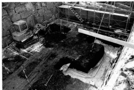
11 基礎工事 掘削
