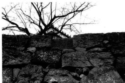
挿図5 現存石垣中央部の 切り欠き
