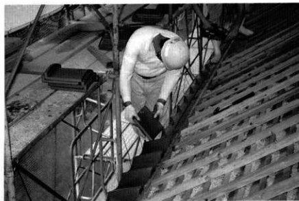
38 敷平瓦・軒平瓦 葺き
