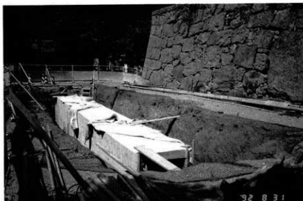
7 共同溝敷設工事
