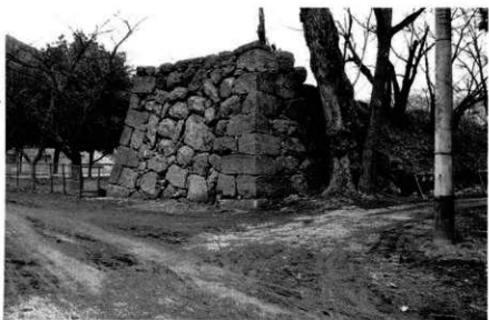
84 二の丸北虎口整備 工事（施工前）
