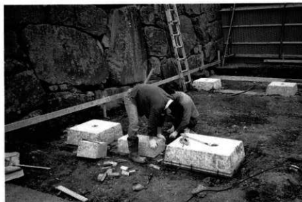
14 礎石、地覆石 据え付け
