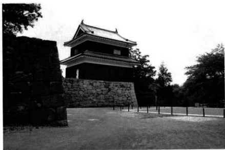
81 本丸西虎口 整備工事
