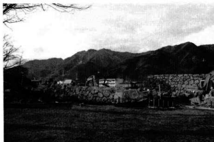
86 二の丸北虎口 整備工事
