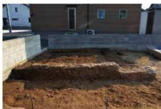
石積み内部の土層断面（東西方向）
