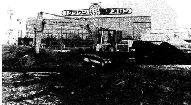
(1) B地区表土除去作業
