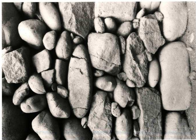
(2) 側壁の石組み状況
