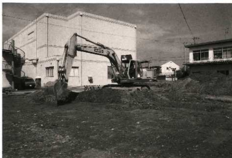
2. バックホーによる表 上発掘状況
