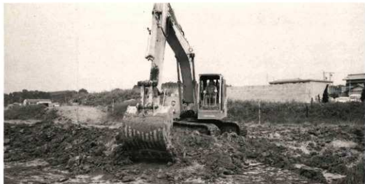
重機による表土の除去。
