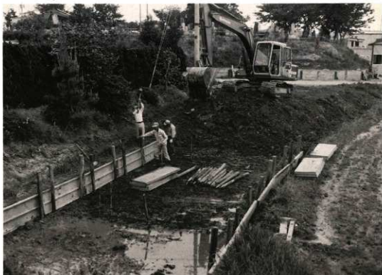
(A) 煙土・表土除去作業
