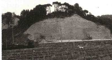
図版1 上石野1号墓遠景（北から）
