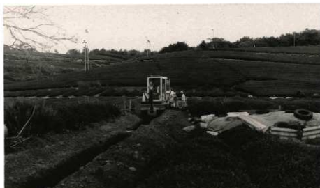
← (A) 農道部分表土掘削状況 (第15トレンチ)
