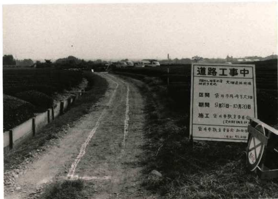
(A) 導水管埋設部分発掘前 (第10トレンチ)
