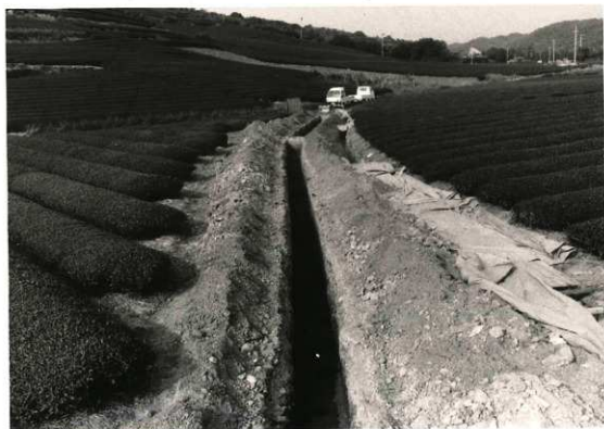
(B) 導水管埋設部分発掘中 (第9・10トレンチ)
