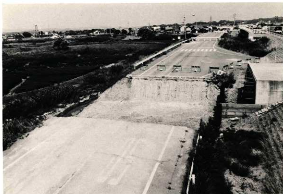
(A) 昭和60年度 第1調査区全景(西より)
