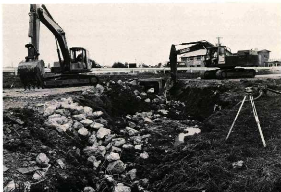
(B) 撤去工事(その2)
