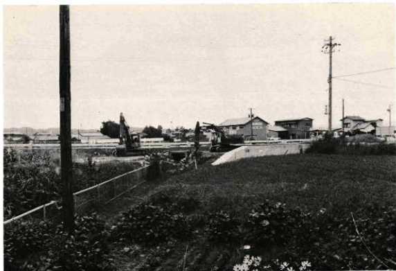
(A) 第2調査区旧用水路撤去工事
