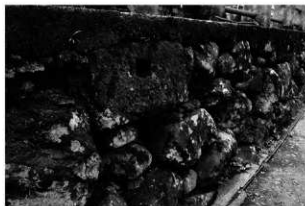
内堀南側石垣の石樋(北より)
