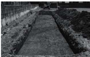
トレンチ検出状況（西より）
