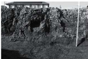
2トレンチ北壁土層 (南より)
