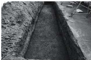
トレンチ検出状況 (西より)
