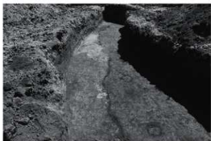
サブトレンチ拡張部検出状況（北西より）
