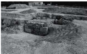
4トレンチ橋台石垣（北西より）
