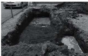
1トレンチ検出状況 (東より)
