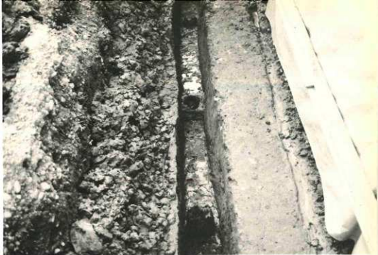
S B 3 柱列出土状況 (南より)
