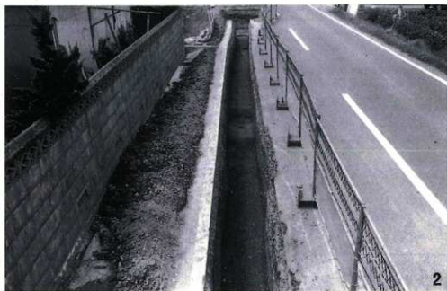
2.3 トレンチ全景 (東より)
