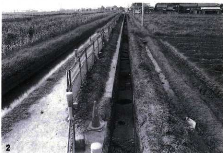
2. 1トレンチ全景 (南より)
