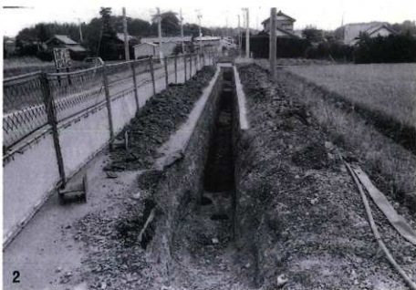
2.4 トレンチ全景 (西より)
