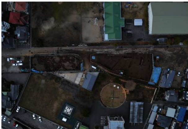
105-1 北側・105-2 第2検出面完掘状況と現存する路地の様子（右が北）
