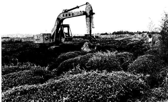
口区表土掘削状況
