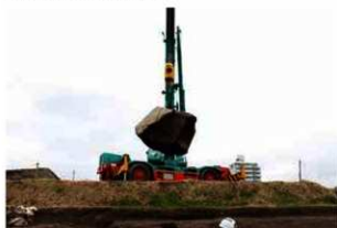
景石11吊り上げ状況(南から)
