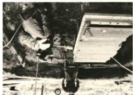
上部よりスチレンス枠をはめ込む
