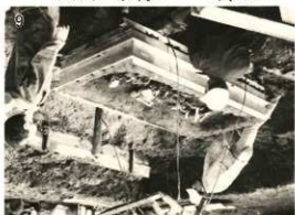
底を電気溶接する
