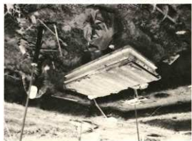
下部をドリルで掘削する
