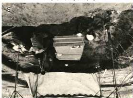
底を電気溶接する
