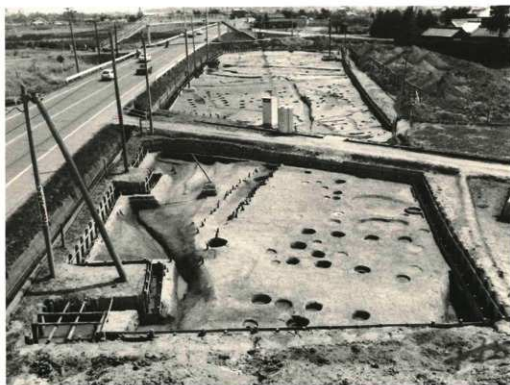
中央区完掘状況（西方より）
