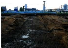
31SD025 完掘時（東より）
