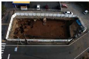
北区第4面 完掘状況 (北西より)
