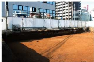
北区西壁 土層断面 (南東より)
