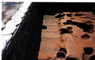
SX630(640) 完壁時 (北より)
