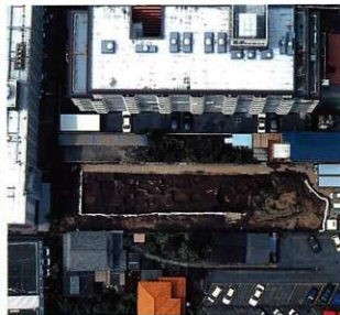
2 調査区全景空中写真（上が西）
