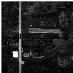
第14図 83次調査区全景（上が北）
