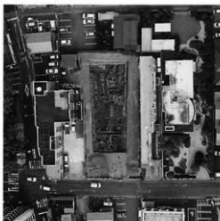
第12図 調査区全景空中写真
