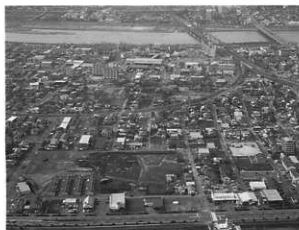
第5図 調査区全景1（東方向から）
