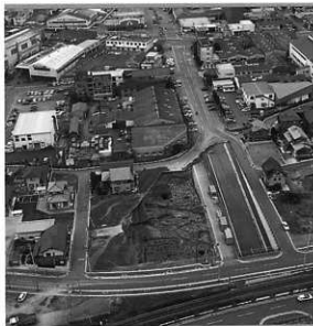
第26図 調査区全景（東方向から）
