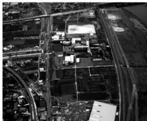
第10図 調査区全景空中写真（南から）
