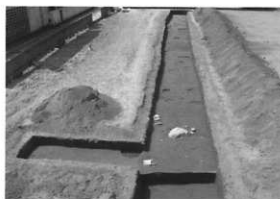
写真36 町46南北トレンチ遺構検出状況（北より）
