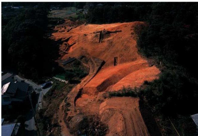
(1) 第2次調査地全景（東上空から）
