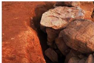
(4) 1号墳玄室西側壁裏込め状況(西から)
