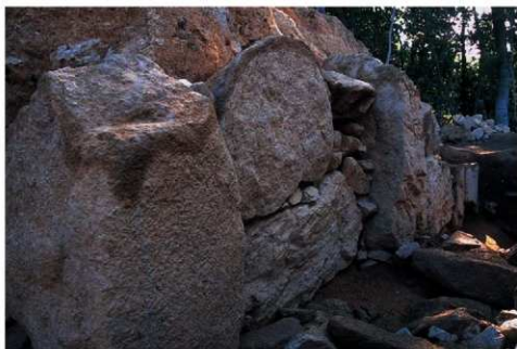
(1) 2号墳前室東側壁（北西から）
