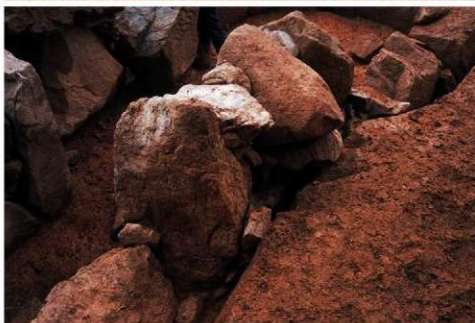
(2) 2号墳前室東側壁裏込め (南東から)
