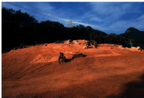
(3) 3号墳地山整形状況全景 (南から)
