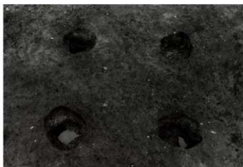
06 2区SB2 北から
