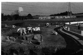
II区作業風景
